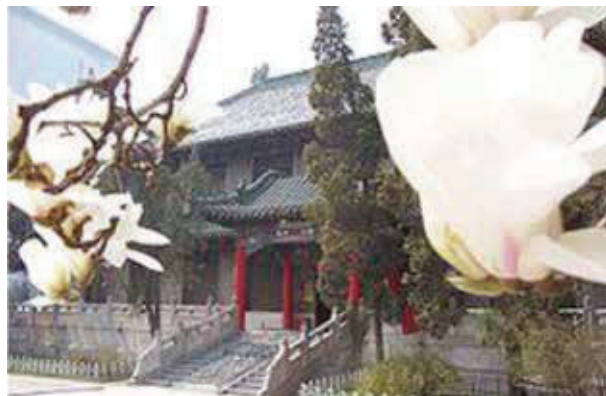
圖四 協和醫學院早期建築（舊址）。
